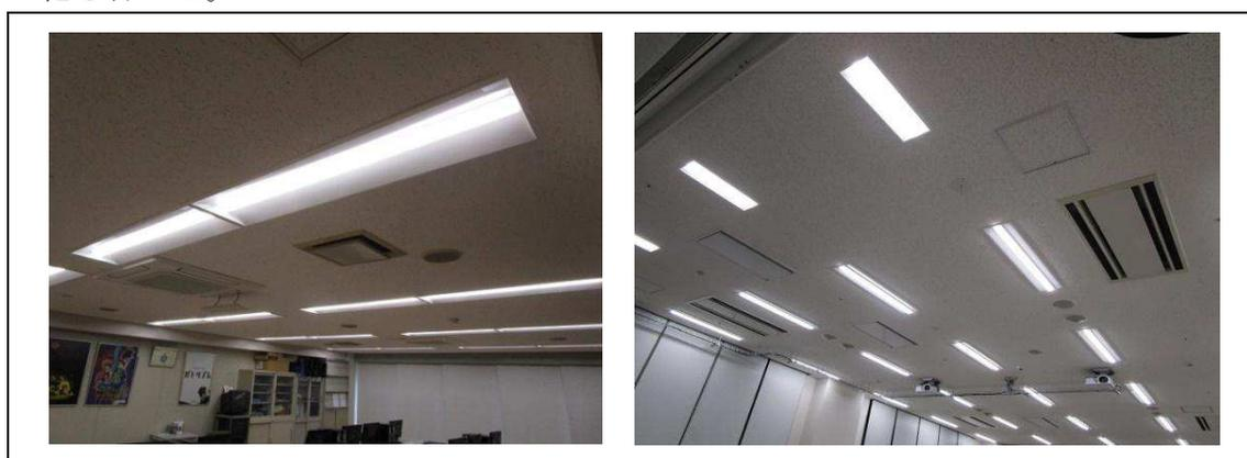
図 2-7 LED 改修例（左：3 号館教室／右：7 号館地下 2 階教室）
